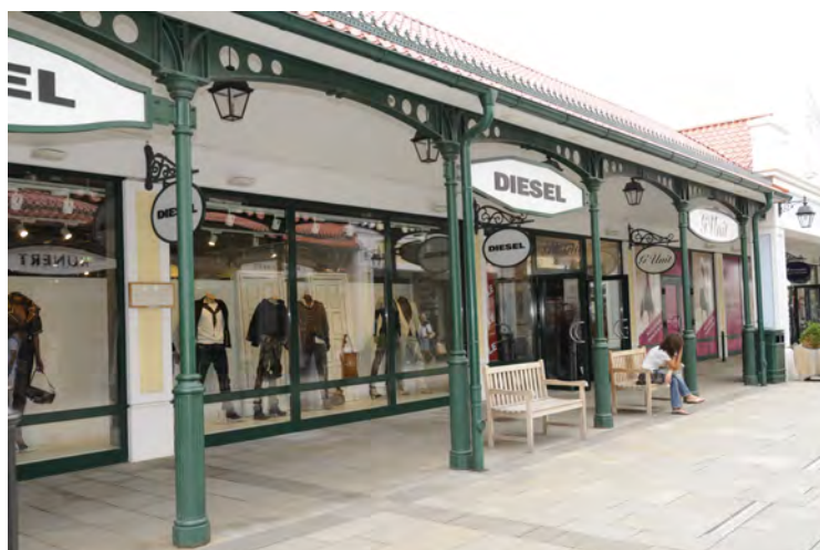
Überdachung: Eisenkonstruktion, Säulen Stahlrohr DM 101 mm mit Säulenteile "Parndorf" aus Gusseisen, Schneerechen am Dach aus Aluminiumguss.
