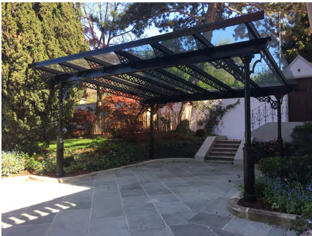
Carport: Eisenkonstruktion, Säulen Stahlrohr DM 101 mm mit Säulenteile " Parndorf" aus Gusseisen und Deckung mit Sicherheitsglas
